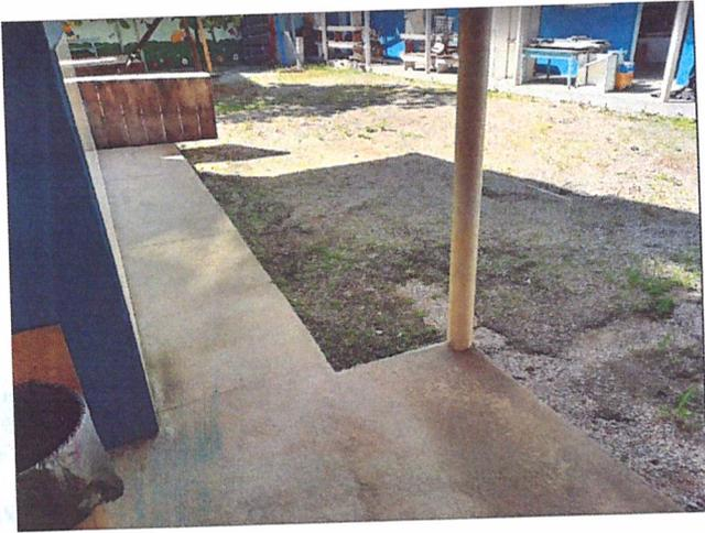
Figura 22: Imagem de calçada com degraus e desníveis que devem ser removidos
