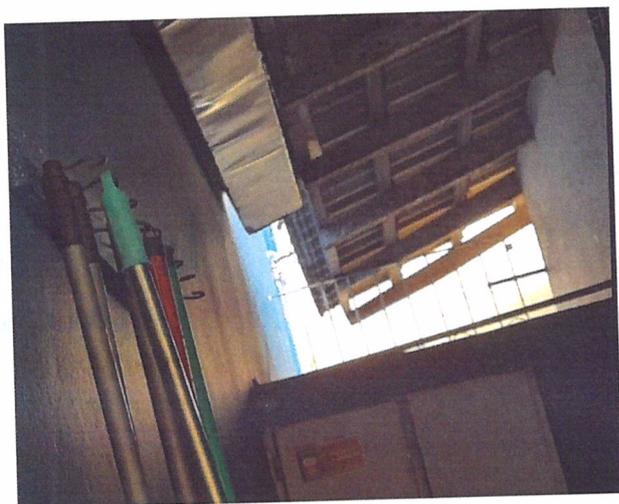
A figura acima mostra que falta de parte da calha parede e a laje que estão próximos recebem muito umidade durante a chuva, provocando uma série de patologias
