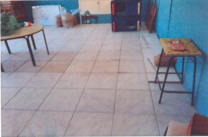
Figura 7: Piso com presença de umidade e fungos
