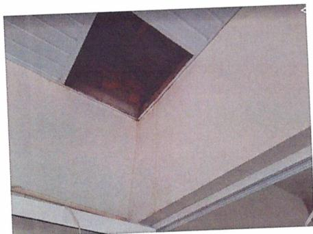
O forro da figura acima deve ser trocado, bem como reparado o telhado que está infiltrando.
