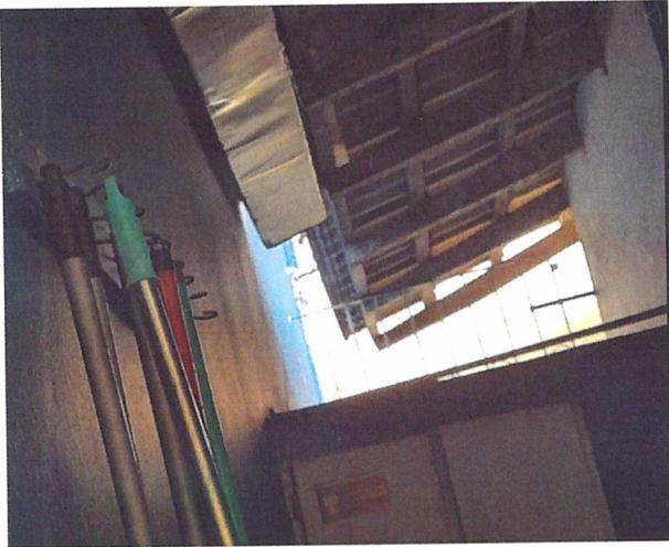
Na figura acima mostra um beiral que está faltando uma parte do beiral o que faz com que as paredes fiquem todas úmidas e com cheiro de bolor nas salas. Portanto deve ser colocada a calha e impermeabilizada a laje que fica embaixo do beiral.
