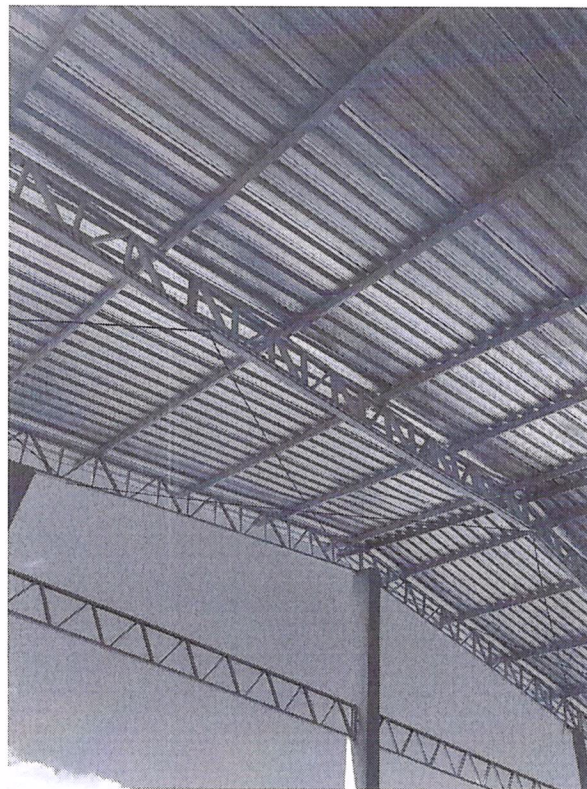
Figura 9: Tirantes de aço
