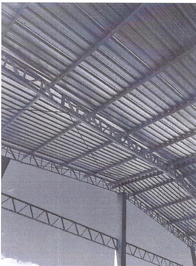
Figura 12: Local da colocação do lambri.
