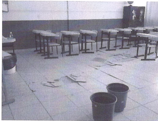
Figura 11: Local da troca de piso.
