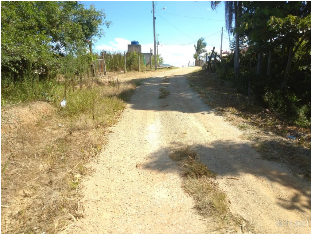
Figura 3 – Vista de trecho da via
