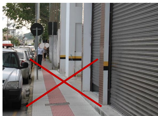
FIGURA 37: CALÇADA IRREGULAR – USO INCORRETO DO PISO ALERTA. BIGUAÇU/SC
