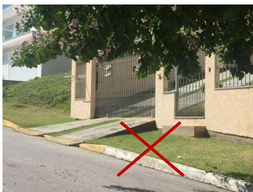
FIGURA 8: CALÇADA IRREGULAR - RAMPA DE ACESSO PARTICULAR NA CALÇADA. BIGUAÇU/SC
