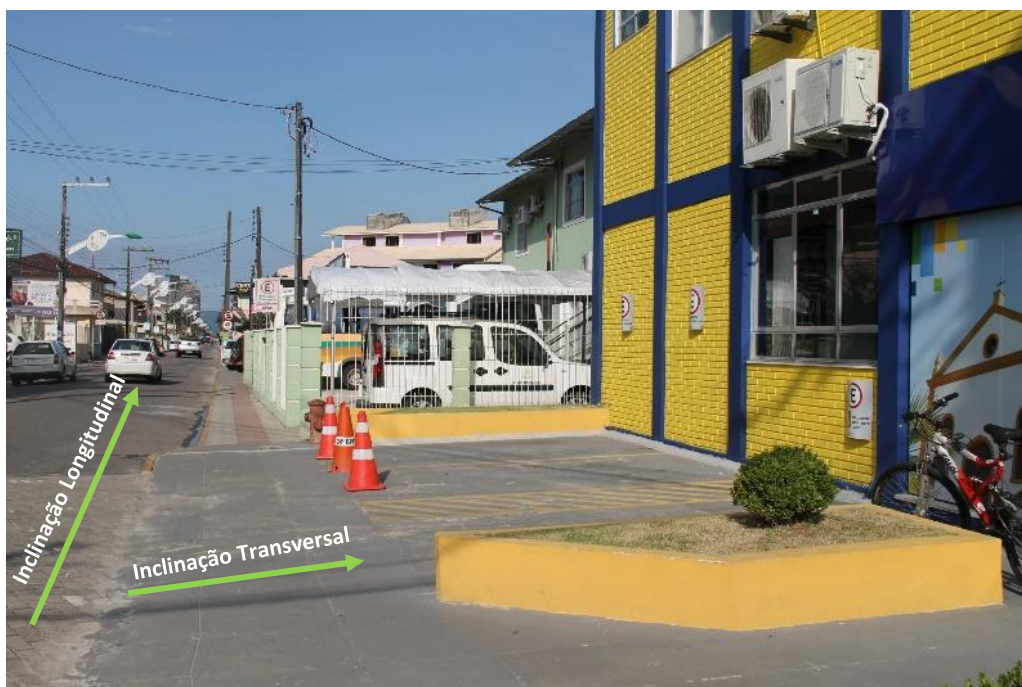
FIGURA 6: INCLINAÇÃO LONGITUDINAL X INCLINAÇÃO TRANSVERSAL. RUA SETE DE SETEMBRO – BIGUAÇU/SC
