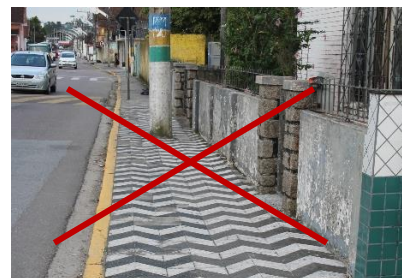
FIGURA 47: CALÇADA IRREGULAR – PADRONAGEM CONTRASTANTE NÃO INDICADA. BIGUAÇU/SC
